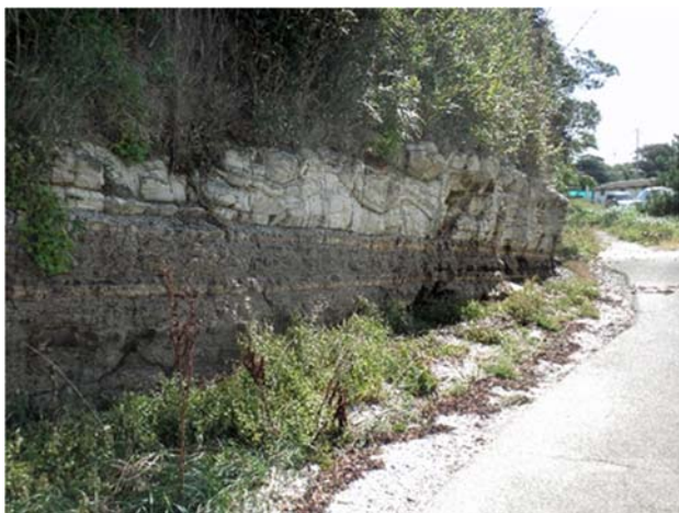
図 9 凝灰質砂岩泥岩互層と層内褶曲 (西港付近)
