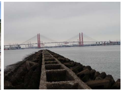
図5 庄内川導流堤（左が庄内川，右が新川）
