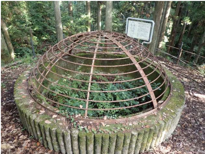
図 6 手掘石油井戸
