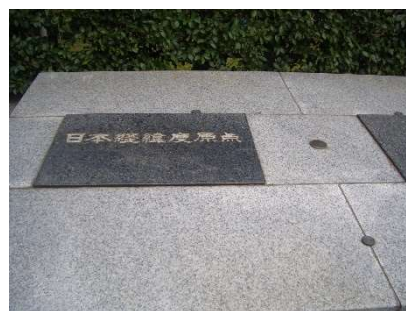
図 6 日本経緯度原点（左の写真の標示板の右側の円い点（右側写真）が原点を示しています）
